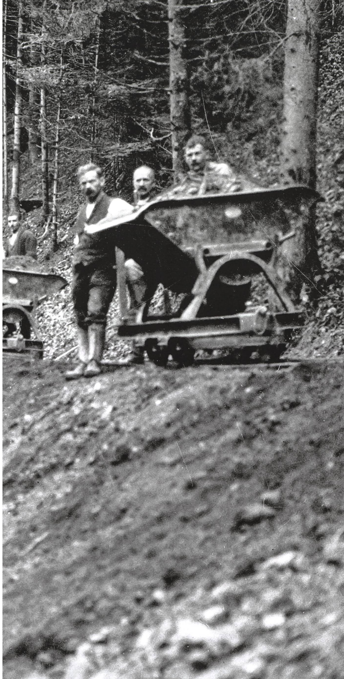
Strassenbau auf der Wernisegg: Rollwagenarbeit im Wald zwischen Gernet und untere Wernisegg. Gebaut wurde die Strasse durch die Bauunternehmung Ferdinand Zettel aus Lutbern (vergleiche Artikel in «Heimatkunde Wiggertal 2025»). Foto zVg von Pius Häfliger, Aufnahme von 1941/42.
