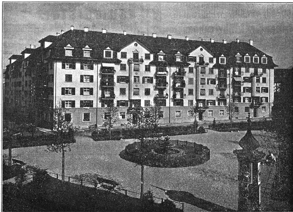
Bauten der Allgemeinen Baugenossenschaft Luzern
