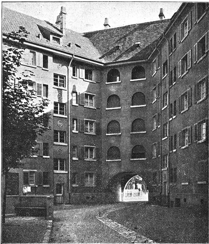
Hofansicht aus der Wohnkolonie an der Josef-Röntgen-Albertstrasse der Baugenossenschaft des eidgen. Personals Zürich
