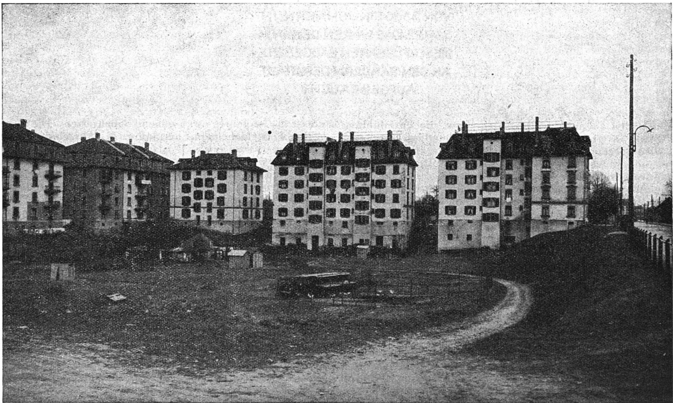
Bebauung in Altstetten Schlechtes Beispiel zufolge Fehlens einer Bauordnung.
