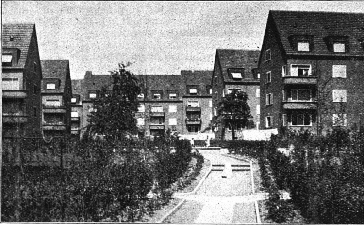
Nördl. Teil der Anlage
