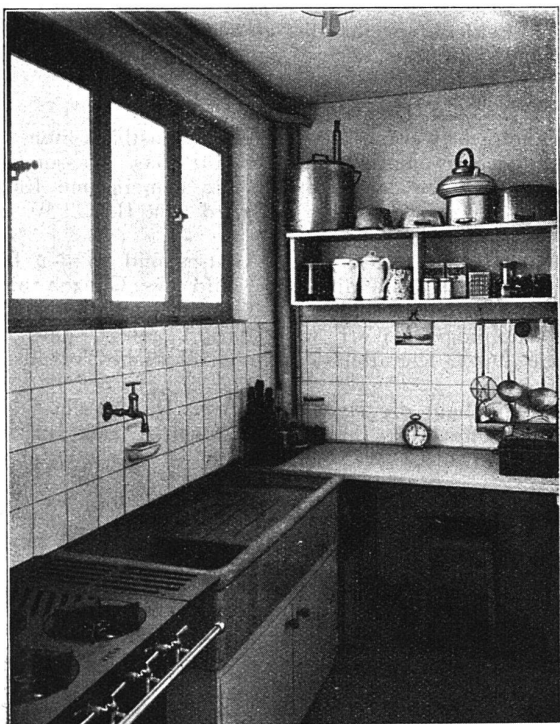
Laubenganghäuser Ansicht einer Küche
