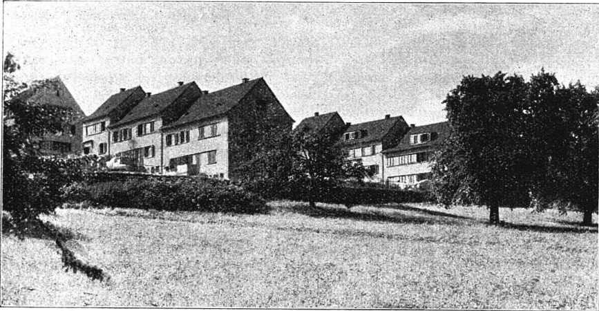
Wohnkolonie Entlisberg der A. B. Z. II. Bauetappe. Einfamilienhäuser
