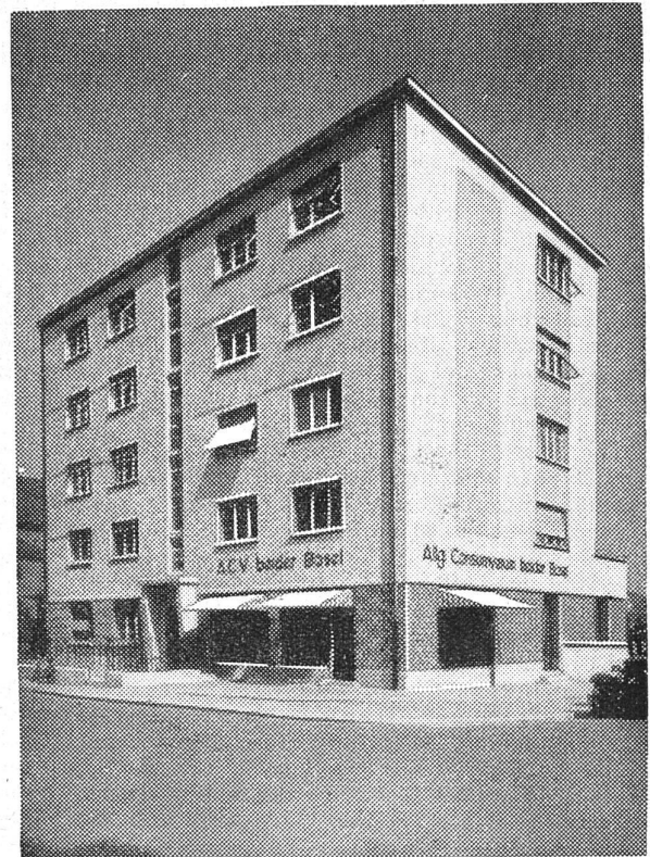
Liegenschaft des A. C. V., Hagentalerstrasse, 1951, Projekt und Bauausführung Architekturbüro A. C. V. Warenfiliale 120 m 2 Grundfläche und 9 Wohnungen zu 2 und 4 Zimmer.
