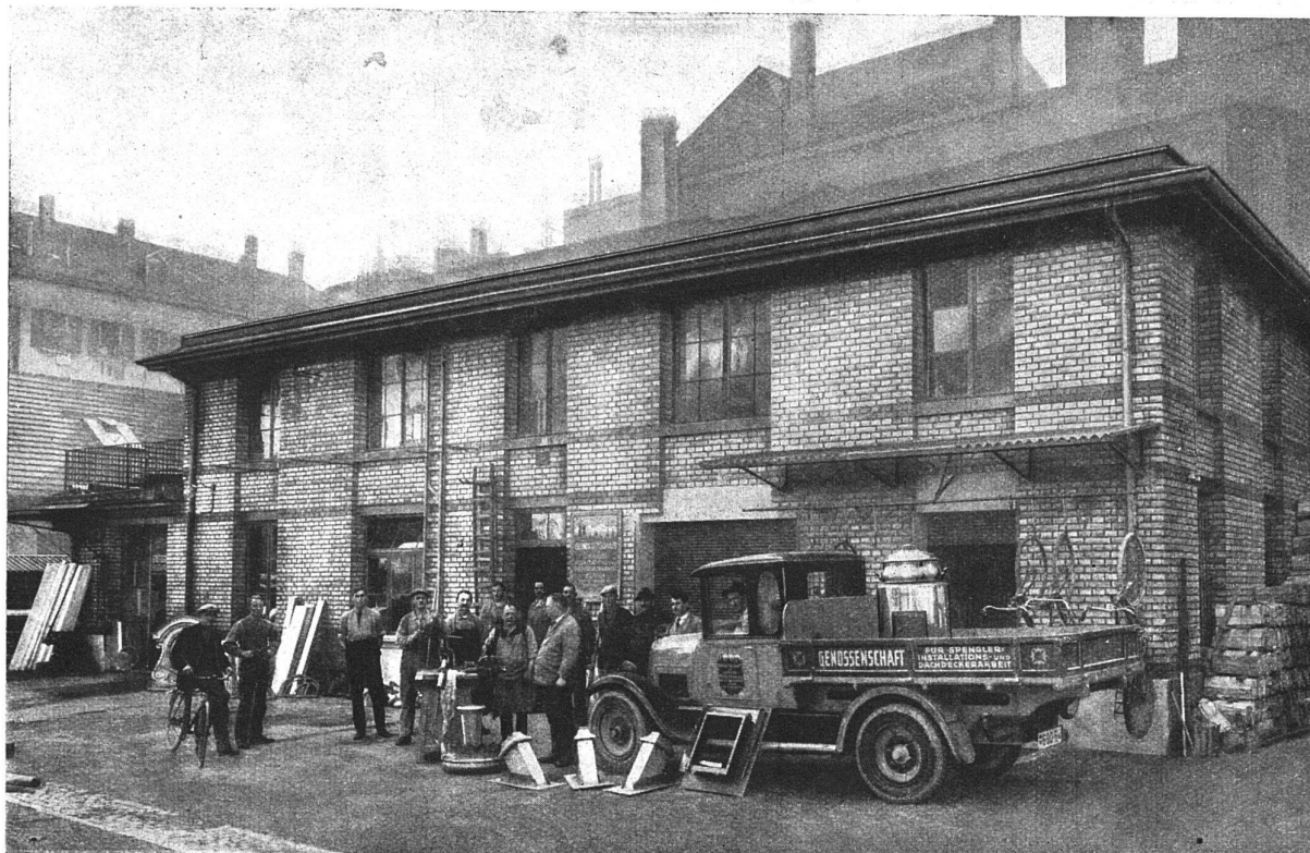
Werkstattgebäude im Hofraum (hinter dem Geschäfts- und Wohnhaus Zeughausstraße 43 gelegen)
