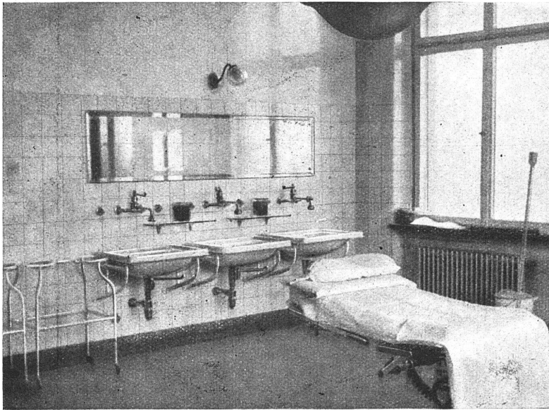
In den Jahren 1916 bis 1919 arbeitete die Installationsabteilung im Neubau der Kantonalen Frauenklinik in Zürich. – Sanitäre Anlage in einem Operationsaal
