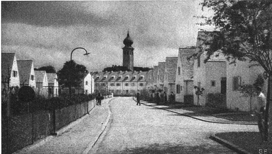
Aus der Mustersiedlung Ramersdorf, im Hintergrund die alte Kirche
