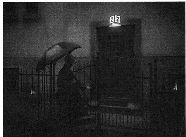
Durchleuchtete Hausnummer. Da die untere Fläche ebenfalls aus Opal-überfangglas besteht, wird auch der Vorplatz gut beleuchtet
