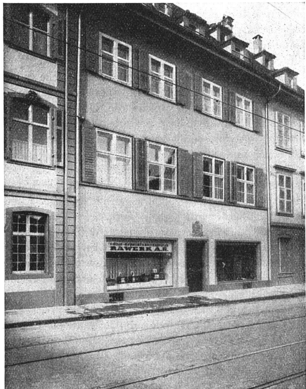
Haus „Zum Mittleren Ulm“ in der St. Johanns-Vorstadt. Es war von Abbruch bedroht und ist nun wieder aufs beste eingerichtet
