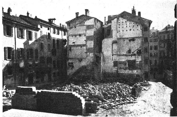
Nach dem Abbruch
