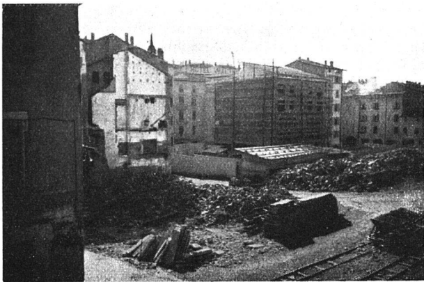
Abbruch und Neuaufbau im Sassello-Quartier
