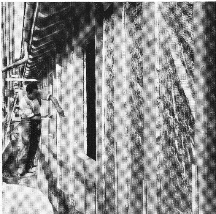
Zwischen die Ständer wird «Alfol» eingespannt.
