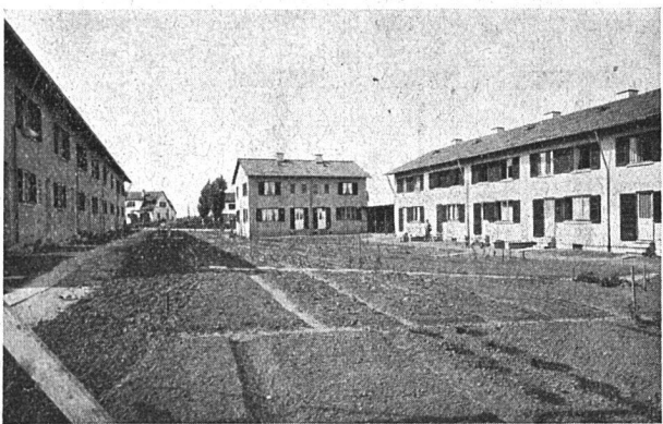
Ansicht der Höfe, zwischen den Häuserzeilen
