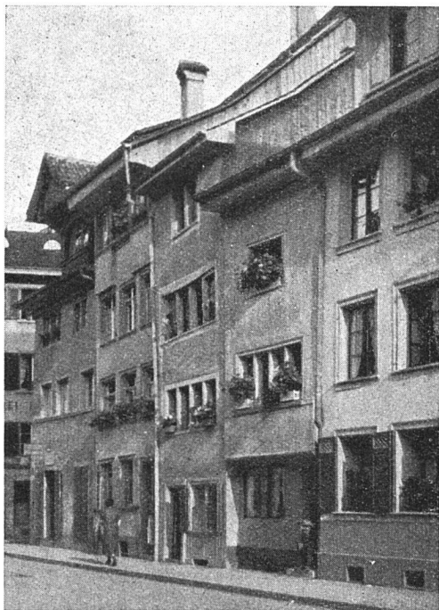
Eine typische Altstadtstraße, die obere Steinberggasse (Südseite)
