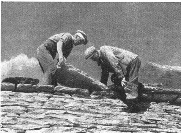
Abb. 5 Beim Verlegen der schweren Dachplatten
