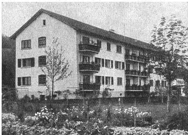
Block 3/4: Ansicht von Süden
