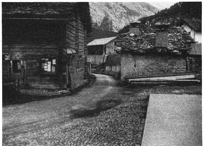
Das alte, baufällige Backhaus in Innerferrera (Graubünden) versperrte teilweise den Verkehr ins Avers-Tal
