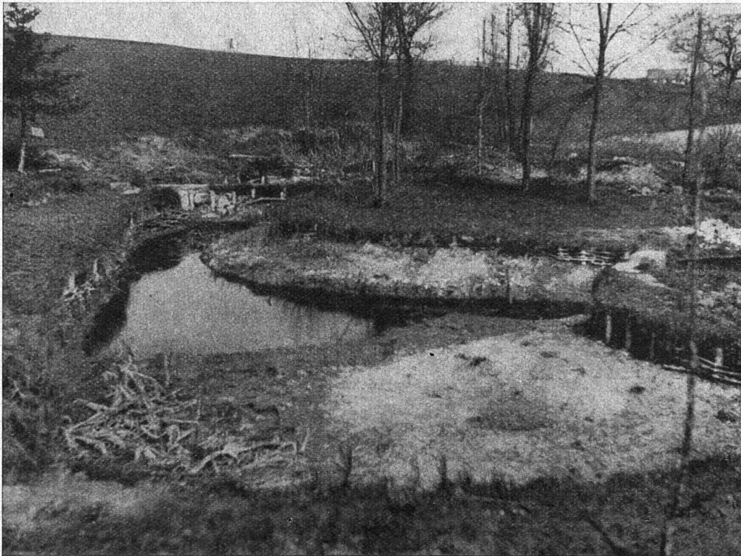
Baugelände für die Siedlung Rothenbrunnen vor der Melioration
