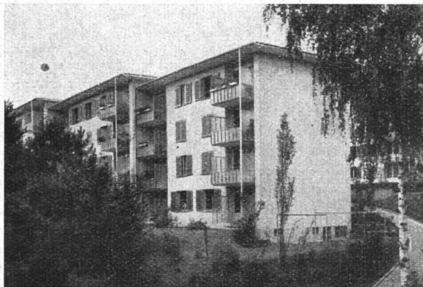
ABZ-Kolonie Waidfußweg II Südansicht vom Waidfußweg
