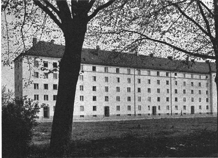
Baugenossenschaft des Verkehrspersonals 1898, e. G. m. b. H., München Wohnanlage Laimer-Platz
