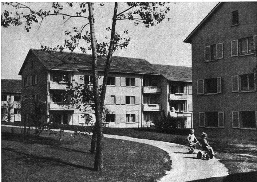
Gemeinnützige Baugenossenschaft «Wiedinghof» Zürich
