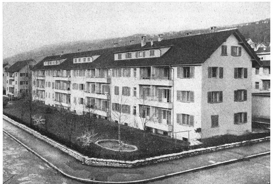
Siedlung «La Champagne» Block Schwalbenstraße
