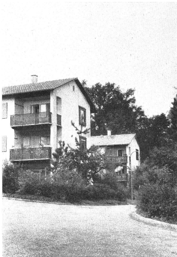
Mehrfamilienhäuser am Jakobsberg
