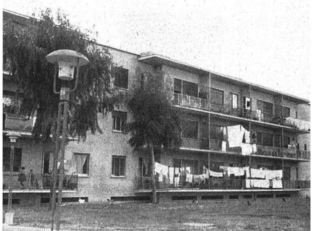
Barra: Eine gute Fassade — und was die Mieter daraus machen
