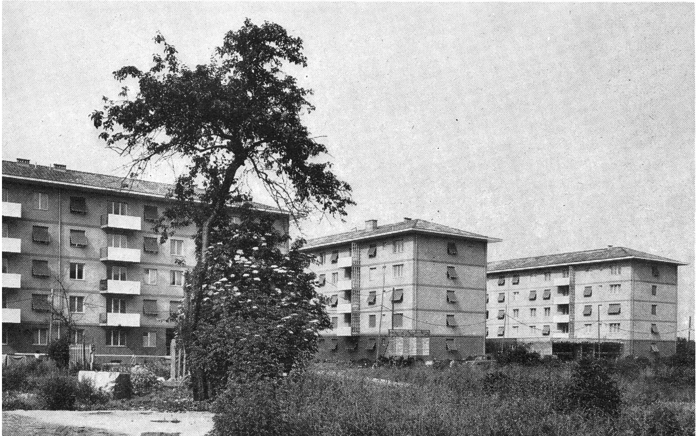
Häusergruppe der Baugenossenschaft «Solidar», Basel
