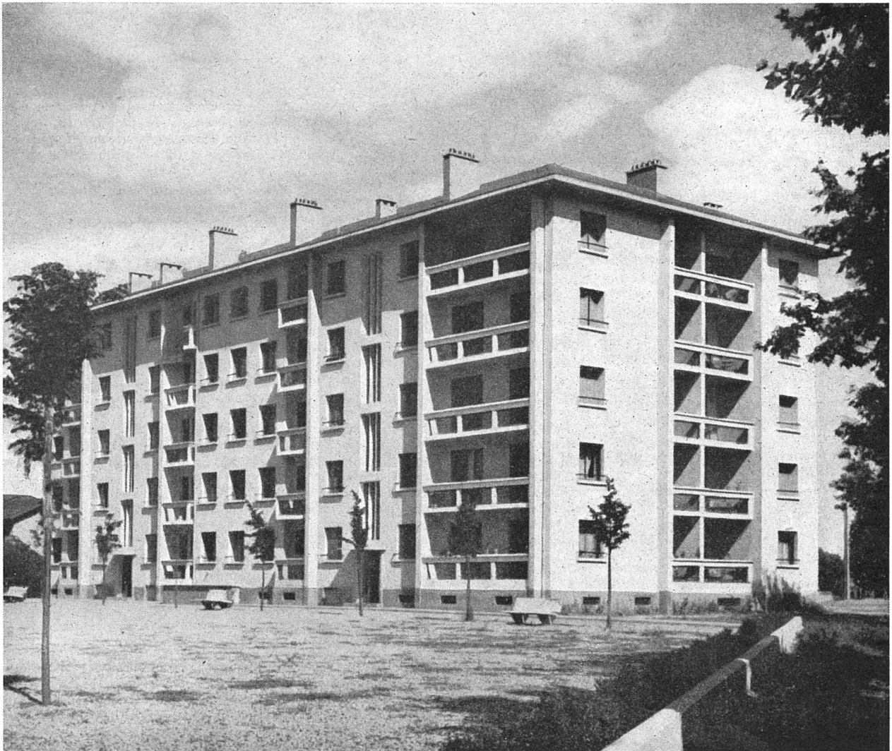
Block des sozialen Wohnungsbaus H. L. M. in Lyon (Rhône). Boulevard A. Paré. (Photo: Ministère de la Construction, France.)
