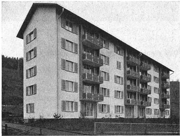
Kolonie Feldmühlehof. Doppelwohnblock mit 20 Wohnungen, in zwei Etappen erstellt, 1958 und 1959.
