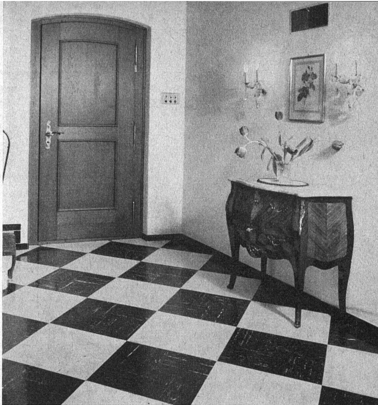
Schachbrettartig verlegte Colovinyl-Fliesen (Photo Zeltner)
