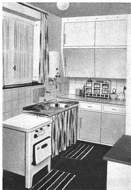
Zwei Küchen nach dem Umbau
