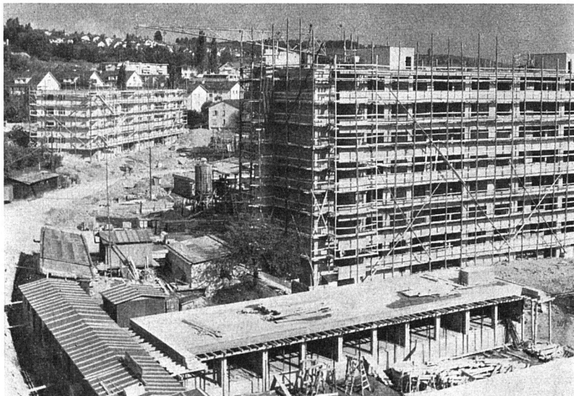
Die Kolonie im Rohbau: Blick von Südosten, im Vordergrund Block B II (sozial), links A II (allgemein und frei), links hinten B I/A I
