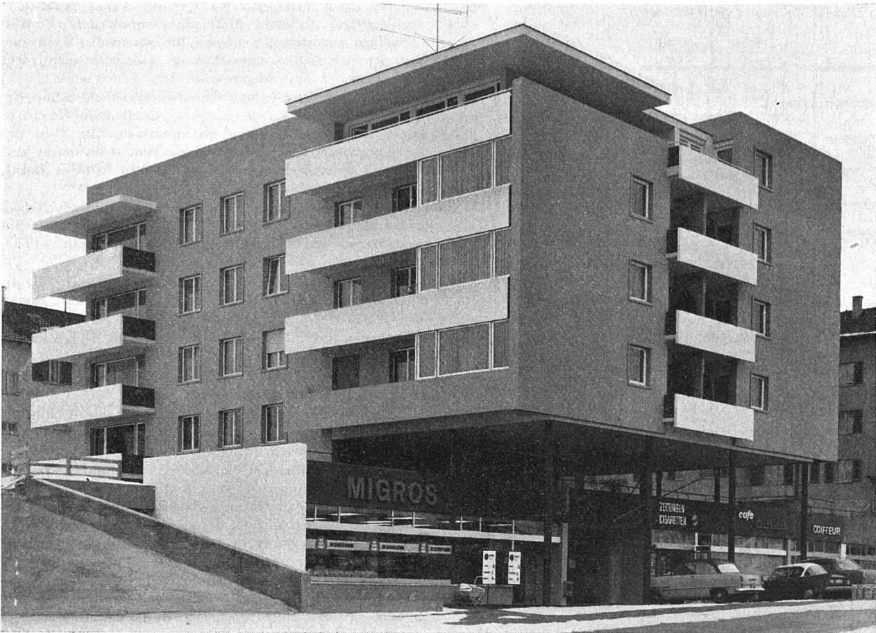
Wohn- und Geschäftshaus Stauffacherstraße, Ansicht von Norden
