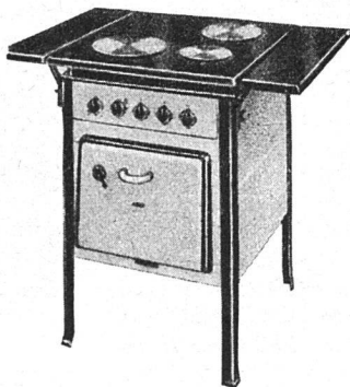
3-Platten-Elektroherd mit Backofen und eisenblech-emaillierter Verkleidung (etwa 1930)
