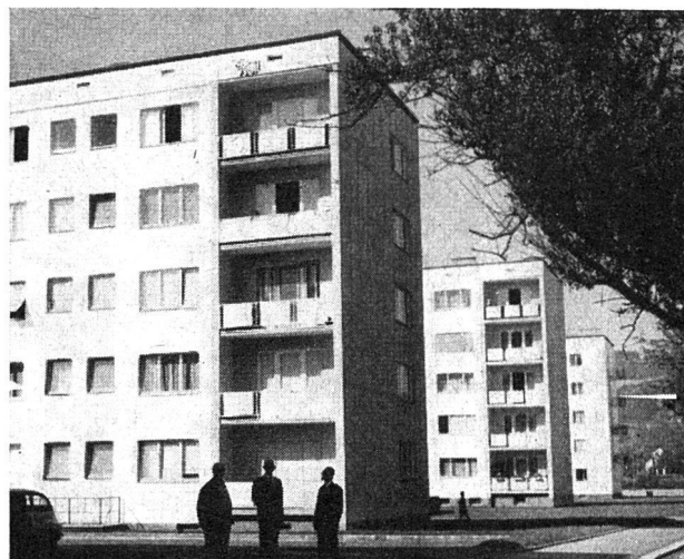
Wohnhäuser der Wohnungsgesellschaft der Stadt in Linz (Oberösterreich)
