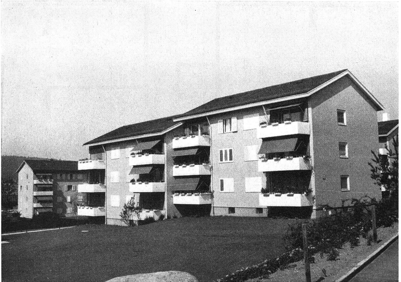
Südwestansicht des Mehrfamilienhauses Kampstraße 4 und 6.
