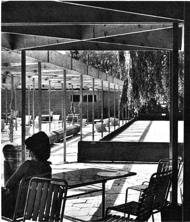
Centre de délassement d'un ensemble résidentiel Erholungszentrum einer Grossüberbauung
