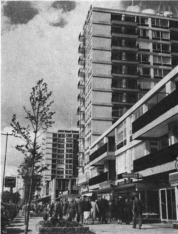
Moderne Wohnbauten in Rotterdam
