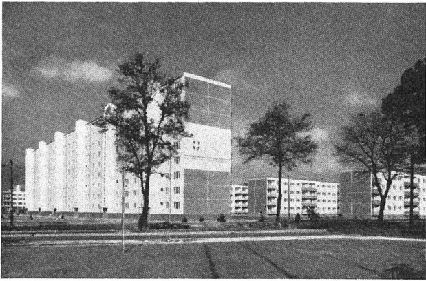
Montagebau in Wien 22, Kagran (Architekten Oskar und Peter Payer).
