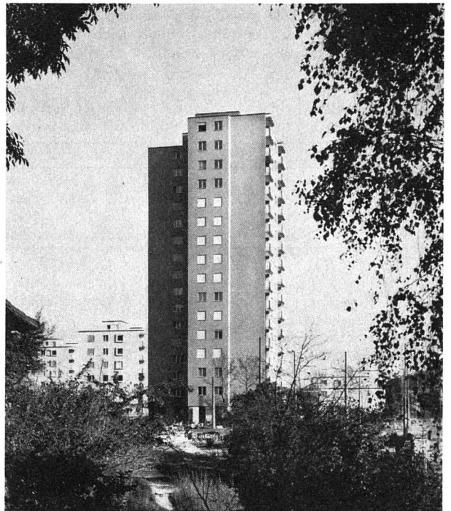
Das Hochhaus der Überbauung «Langwiesen» in Winterthur wurde in 17 Monaten fertiggestellt. Durch sorgfältige Planung wurde mit den konventionellen Methoden des Backsteinbaues eine wirtschaftliche Lösung gefunden, welche auch in den günstigen Mietpreisen zum Ausdruck kommt.
