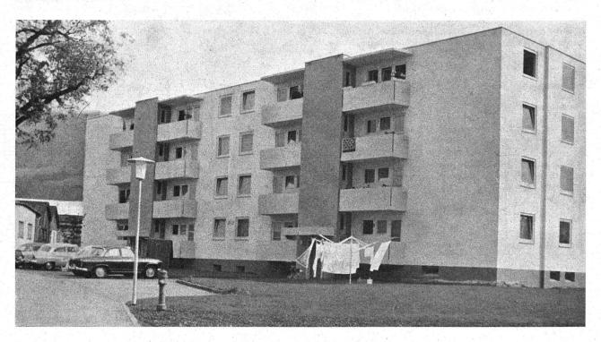
Die Umfassungswände der Wohngeschosse wurden mit Isoliersteinen 18 cm stark gemauert und zur Erreichung einer einwandfreien Isolation inwendig mit Duplexplatten 7 cm stark hintermauert. Alle Geschossdecken sind aus Eisenbeton; die Geschosstreppen aus Kunststein; die inneren Scheidwände aus Backsteinen, Zellton oder Gipsplatten. Das Flachdach erhielt eine Isolation aus 4-cm-Korkplatten und das landesübliche Kiesklebedach.
