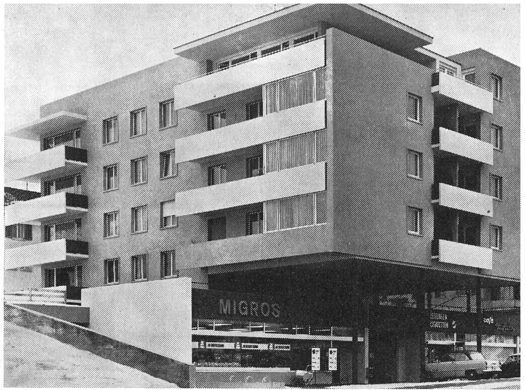
Oben: Wohn- und Geschäftshaus «Stauffacher» der WOGESA Schaffhausen
