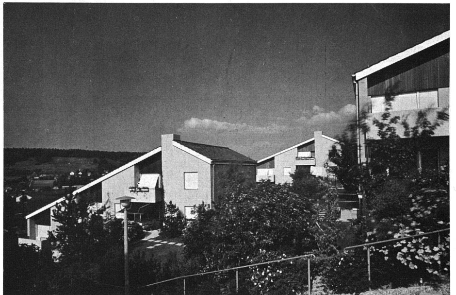
Dreier-Einfamilienhausgruppe, Detail aus der Überbauung Bergblumenstrasse, Baujahr 1967/68. 5½ Zimmer mit separater Garage.
