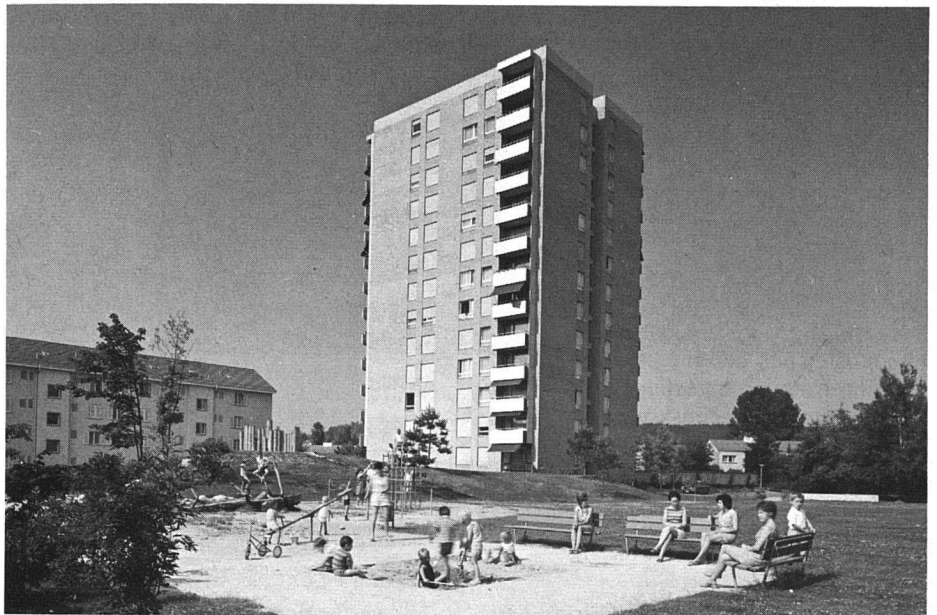
Hochhaus am Buck mit 52 Wohnungen auf 13 Stockwerken, Baujahr 1967. 3- und 4-Zimmer-Wohnungen, Mietzinse Fr. 315.- bis Fr. 475.-
