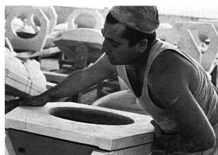
Aufsetzen der Abdeckplatten
