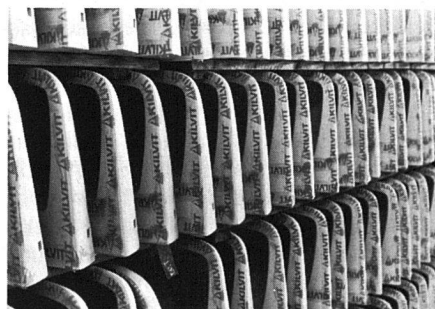
Die endlose Kette von Sanitärapparaten.
