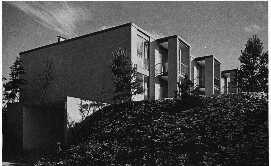
Eine der Gebäudegruppen mit unterirdischer Zufahrt zu den Wohnungseingängen und Garagen.
