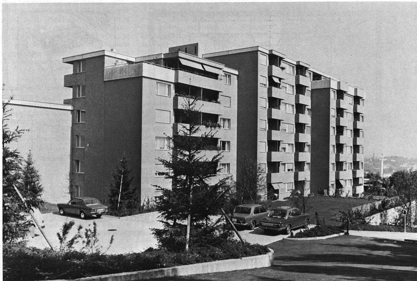
Unten: Ansicht des Hauptkomplexes von Süden
