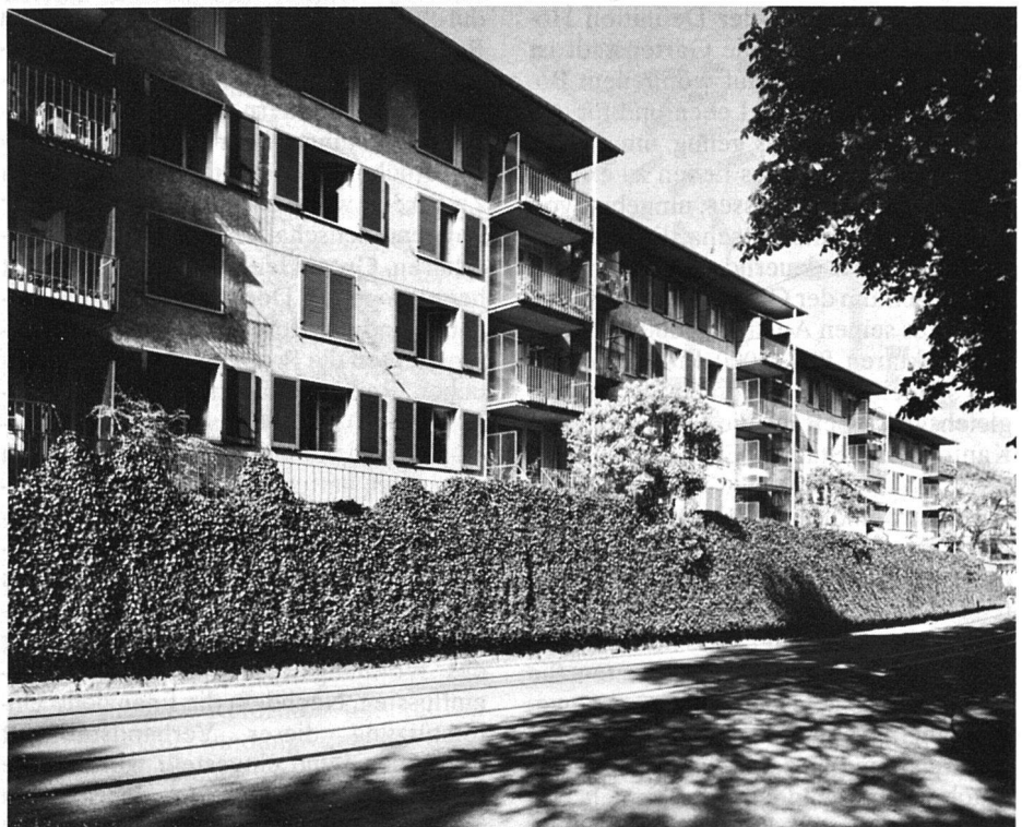
ABZ Kolonie am Waidfussweg Zürich 1935: Ein Beispiel sauberer Baugesinnung
