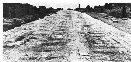
Prunkstrasse im alten Babylon. Die Fugen zwischen den Steinplatten sind mit einer Mischung aus Naturasphalt und Sand vergossen.
