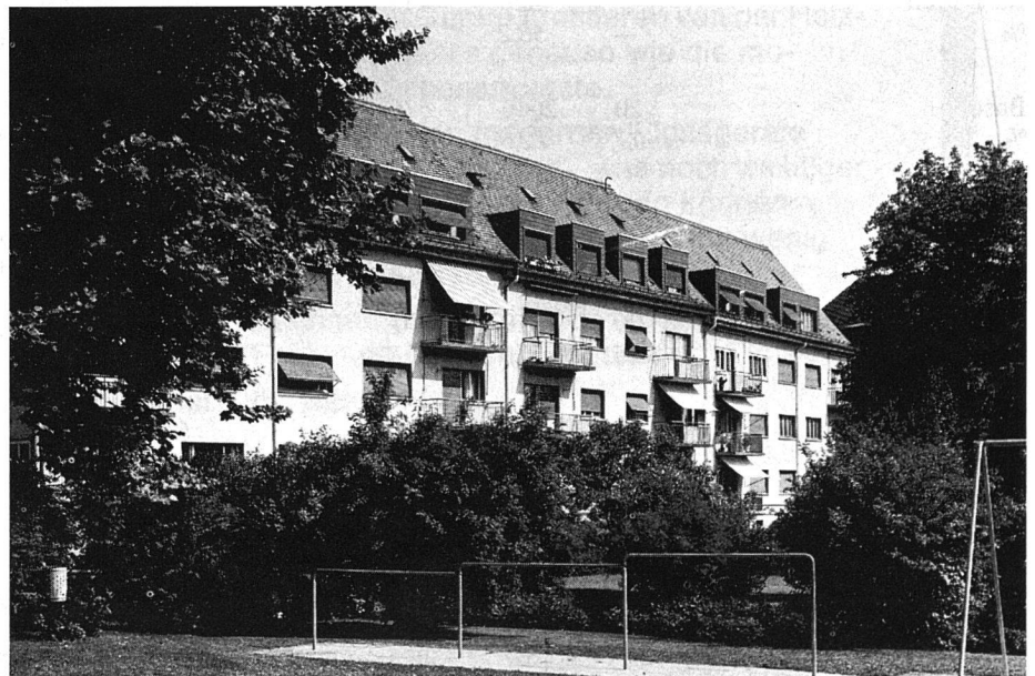
Erneuerung im Gange (Photos Scheiwiller)
